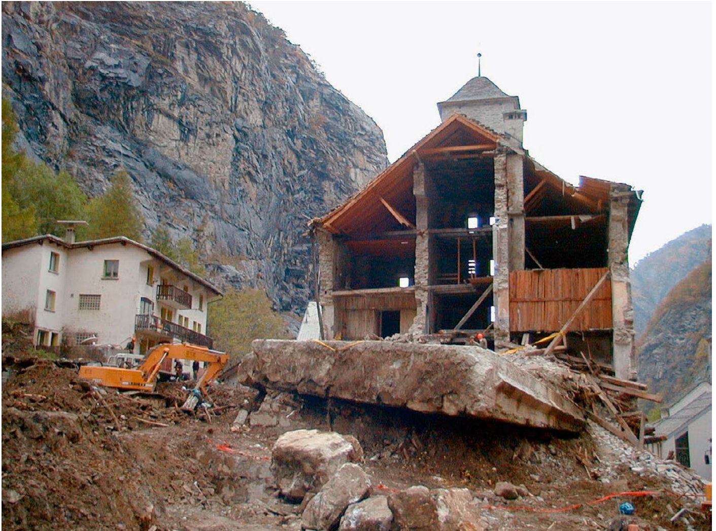
Zerstörungen nach dem Bergsturz in Gondo am Simplonpass.
