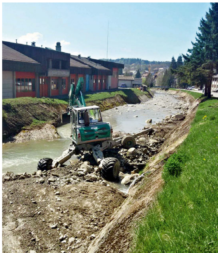
Baggerarbeiten in der Veveyse in Châtel-St-Denis. Bild: Surchat SA
