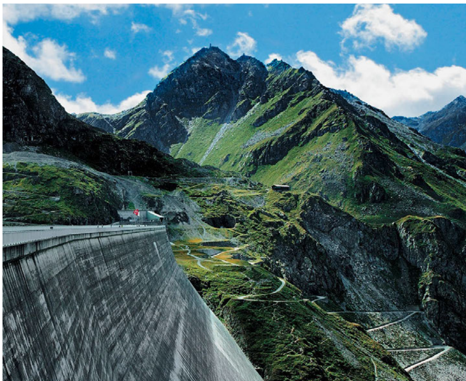
Die Staumauerkrone der Grande Dixence.
