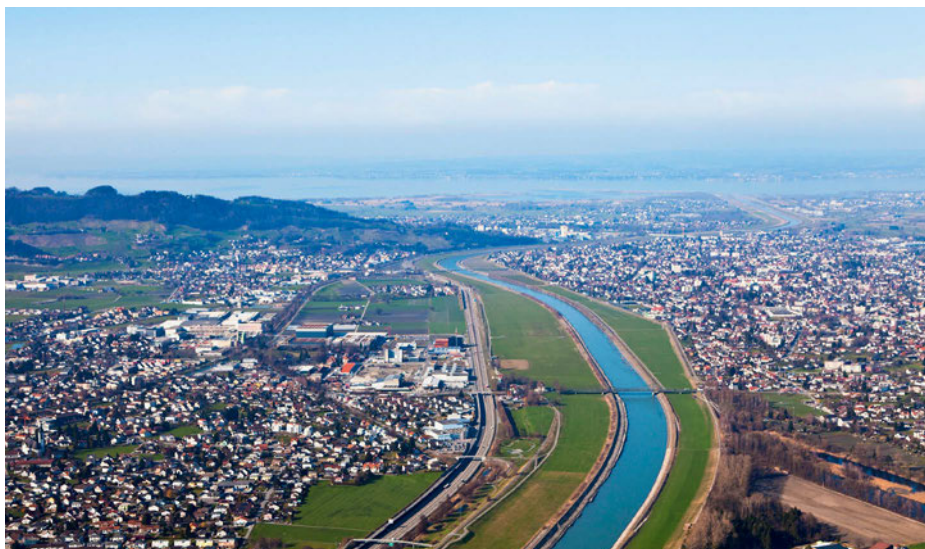
Kanalisiert und eingezwängt. An den Ufern leben 200 000 Menschen. Der grüne Streifen am Fluss wird intensiv bewirtschaftet.
